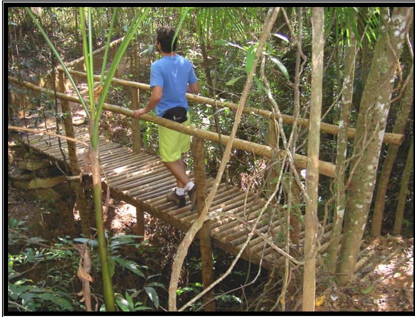
Figura 5: Ponte de madeira com corrimões que auxiliam a travessia em ambiente natural sensível e susceptível a impactos da visitação. A existência dessa facilidade permite maior contato do visitante com o ambiente preservado sem, no entanto, provocar os impactos físicos e efeitos negativos da visitação.
