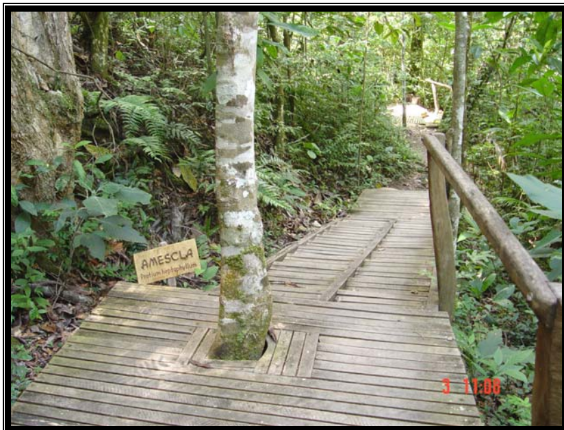
Figura 6: Passarela e Escada (trilha suspensa). Observa-se o cuidado construtivo de manter a natureza mais próxima do visitante (árvore no meio do caminho), e a delimitação bem definida do espaço destinado ao trânsito evita o alargamento da trilha e o pisoteio do solo e da vegetação.
