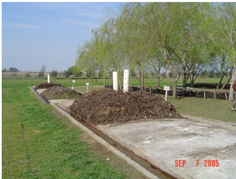
Figura 5: Pátio de compostagem impermeabilizado com canaleta para coleta do chorume. Local: Pergamino/Argentina
