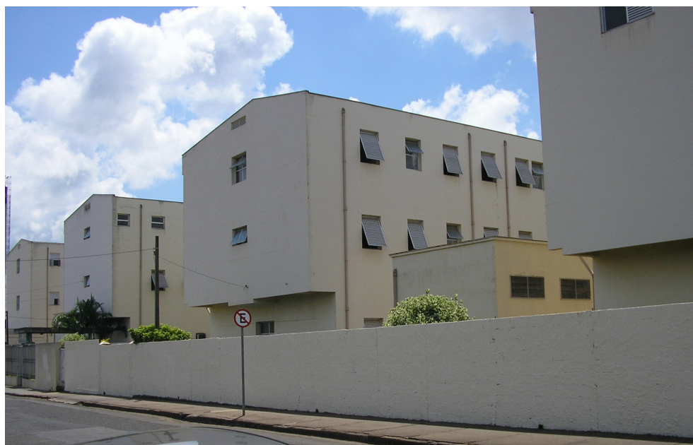
Figura 6 – Vista parcial dos Blocos B, C, D e E, onde se localizam as alas de internação
