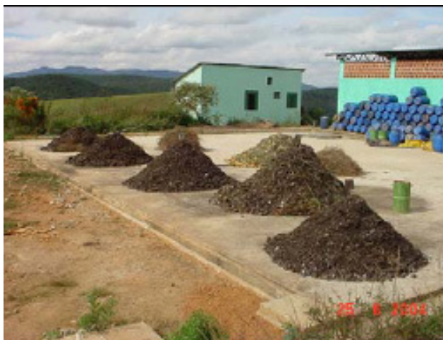
Figura 6: Pátio de compostagem impermeabilizado com concreto usinado a 90 kPa. Canaletas com 10 cm de largura e 20 cm de profundidade
