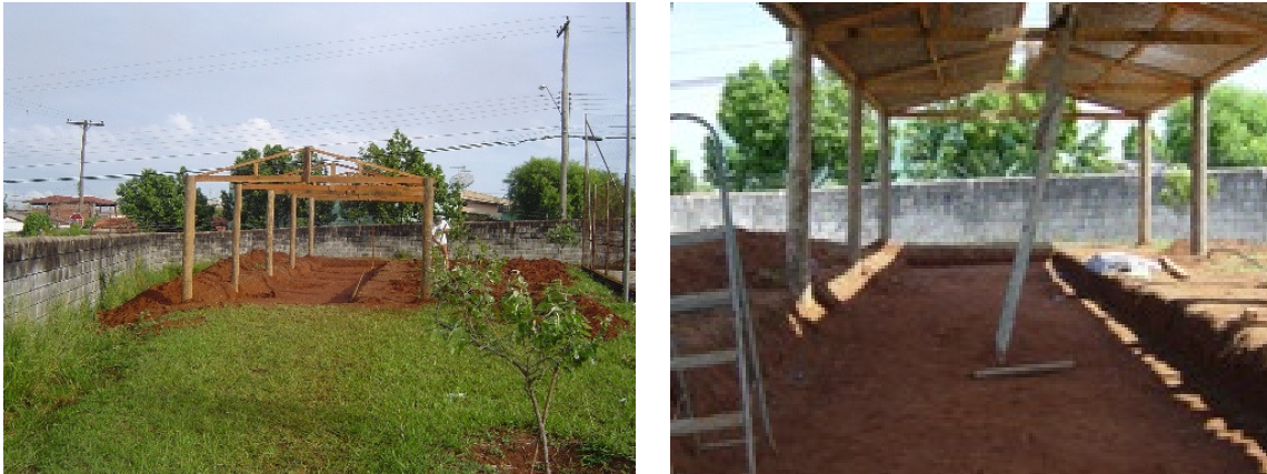
Figura 4: fotos da construção do Pátio de Compostagem (mar/2005)
