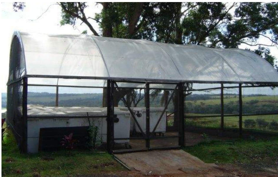
Figura 2 – Célula de armazenamento temporário de RSS no aterro sanitário de São Carlos, SP
