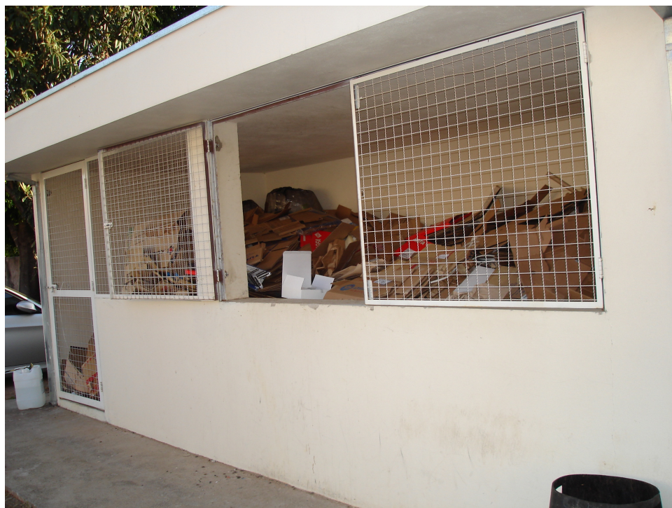
Figura 10 – Sala de armazenamento de resíduos recicláveis Fonte: pesquisa de campo do autor.
