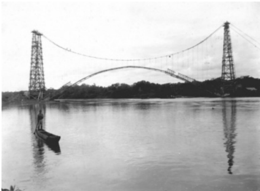
Figura 17 – Construção da Ponte Novo Oriente
